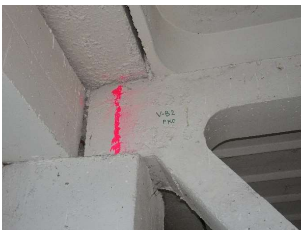
Obr. 7.4: Celkový pohled na lokaci sekané sondy styčníku SLOUP-VAZNÍK VB-2
