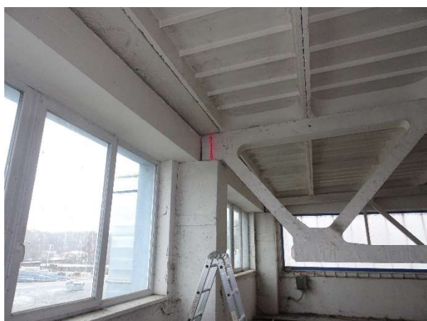
Obr. 7.4: Celkový pohled na lokaci sekané sondy styčníku SLOUP-VAZNÍK VB-2
