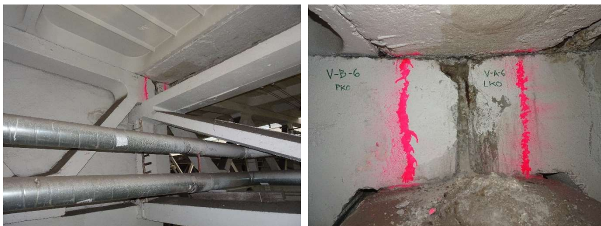
Obr. 7.6: Celkový pohled na lokaci sekané sondy styčníku PRŮVLAK–VAZNÍK VA-6–VAZNÍK VB-6
