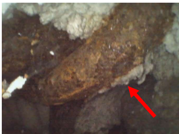
Obr. 7.5: Detailní endoskopické snímky výskytu koroze a korozních produktů v místě sekané sondy styčníku SLOUP-VAZNÍK VB-2
