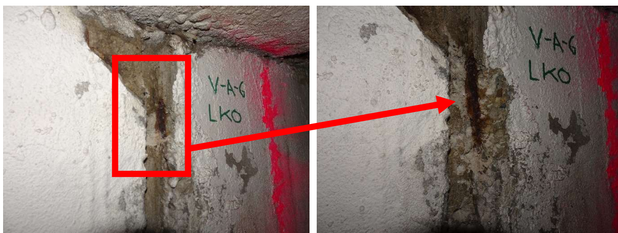
Obr. 7.7: Detailní snímky výskytu koroze a korozních produktů v místě sekané sondy styčníku PRŮVLAK–VAZNÍK VA-6–VAZNÍK VB-6
